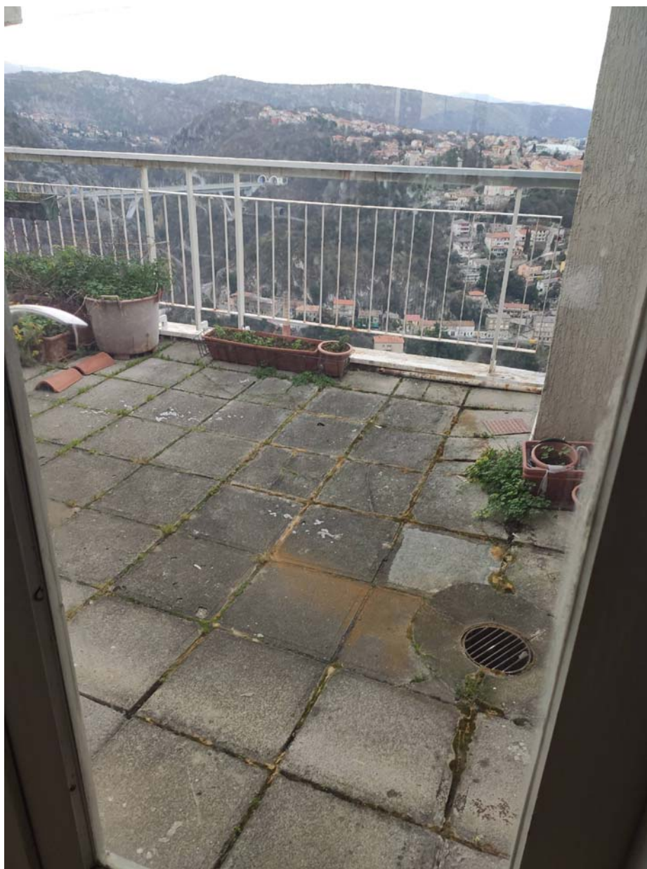
Prikaz ravnog krova - prohodne terase
