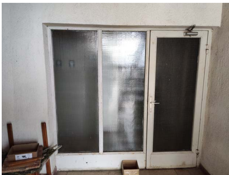
Stolarija na požarnom ulazu
